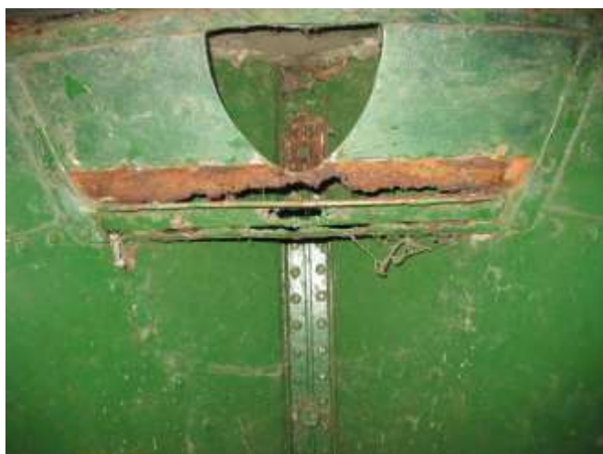
Klapmuts voor restauratie
