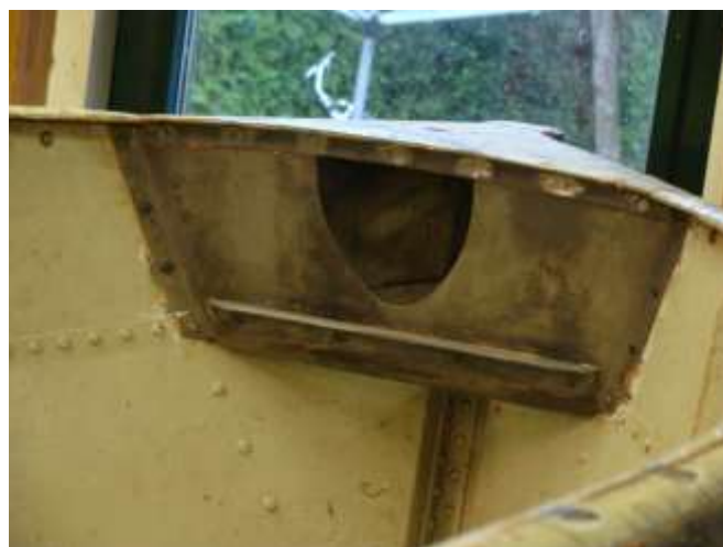
Klapmuts na restauratie
