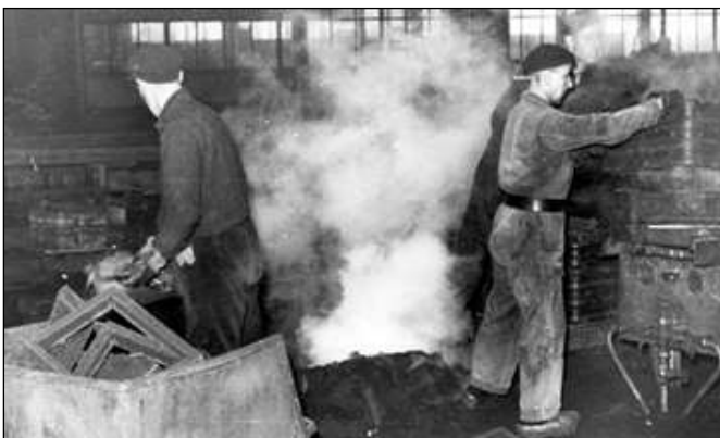
Uitbreken vormen producten en gieten in vormen in gieterij
