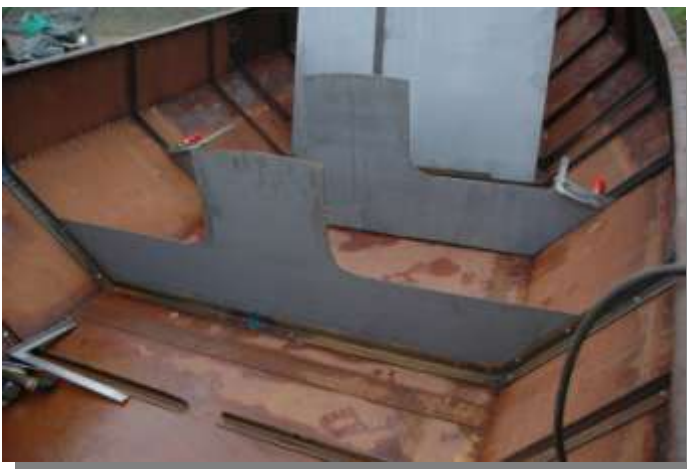
Zijkanten van de beun aanbrengen
