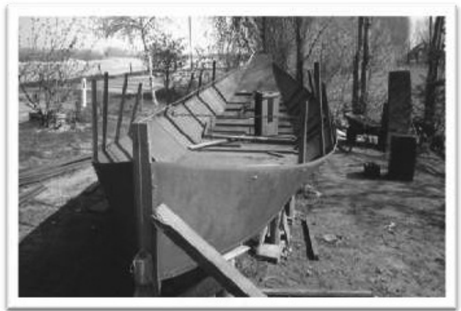
De onderboorden en spanten zijn aangebracht.
