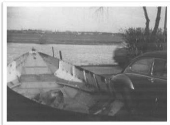
De opbouw is verwijderd.
